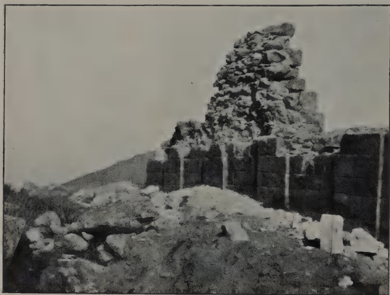
FIG. 152.—No. 35, exterior of N. wall.
